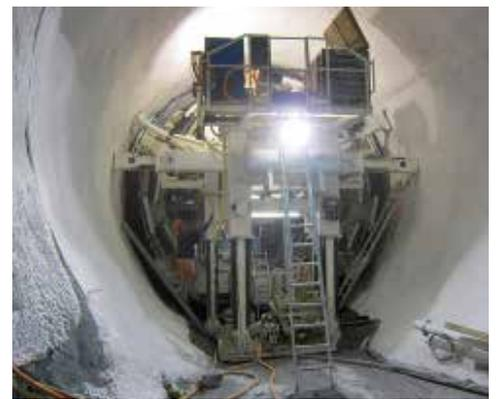
Fullroundschalungen sind aufwändig zu planen und herzustellen. Die Geometrie und der Ringanschluss müssen exakt an die Deformationen angepasst werden, die beim Betonieren eintreten. Ein späteres Ausschaln ist sonst unmöglich. Als zusätzliche Schwierigkeit kamen bei den Fullroundschalungen des neuen Pumpspeicherkraftwerks Limmern Steigungen bis zu 22 % sowie aussergewöhnlich enge Platzverhältnisse hinzu.
